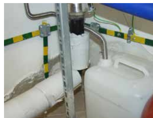
Fot. 3.3. Ilustracja dość niskiej jakości prac wykończeniowych w zakresie izolacji rur wewnątrz pomieszczeń
