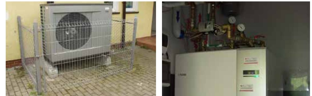
Fot. 18.1. Dokumentacja fotograficzna instalacji świetlicy wiejskiej w Mierzynie (gmina Karlino)
