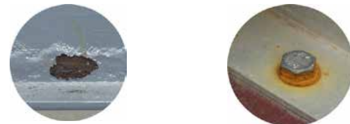
Fot. 3.1. Widok elementów konstrukcyjnych niepoprawnie zabezpieczonych przed korozją oraz nieodpowiedniego doboru materiału połączeń śrubowych
