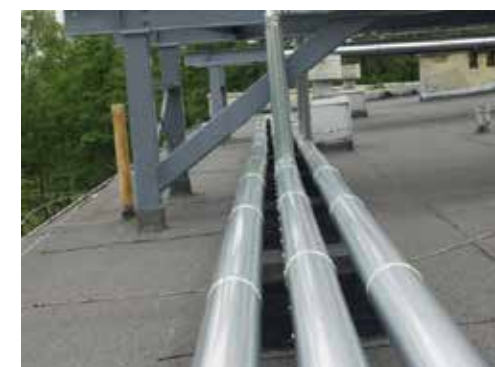
Fot. 3.4. Przykłady instalacji godnych naśladowania w zakresie wykonania izolacji, zabezpieczenia rurociągów na zewnątrz oraz przejść dachowych (Polska)
