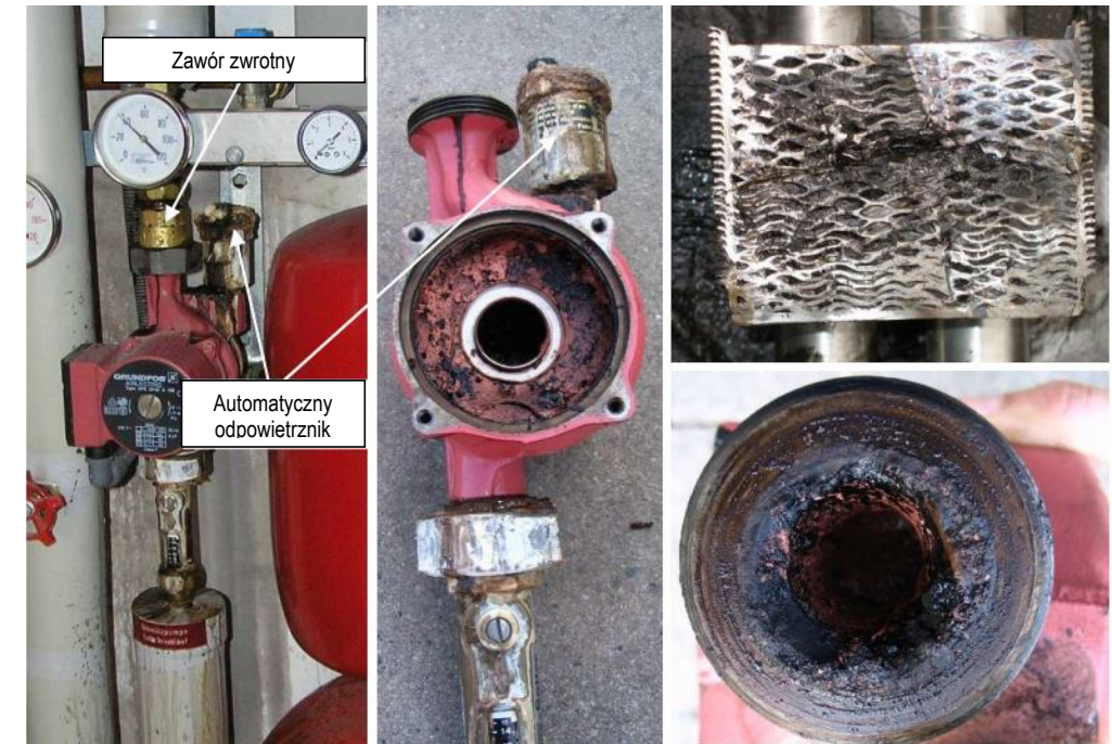
Rys. 1.20. Ilustracja uszkodzeń w pozostałych komponentach instalacji kolektorów słonecznych (zawór zwrotny, pompa obiegu kolektorów, wymiennik płytowy) – źródło [7 i 8]
