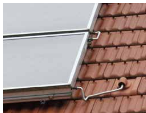
Fot. 3.2. Brak zabezpieczenia, utlenianie materiału izolacyjnego, przegrzewanie instalacji oraz uszkodzenia przez ptaki skutkują całkowitym zanikiem izolacji
