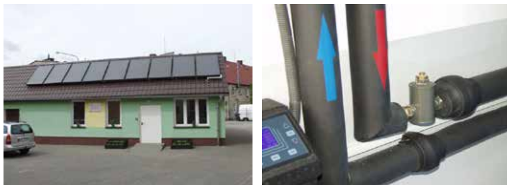
Fot. 10.3. Ilustracja instalacji kolektorów słonecznych w Placówce Opiekuńczo-Wychowawczej „Dzieciowisko” w Świdwinie (gmina Karlino, Polska)
