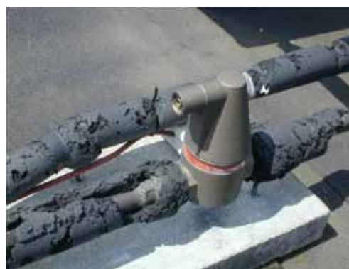
Fot. 3.2. Brak zabezpieczenia, utlenianie materiału izolacyjnego, przegrzewanie instalacji oraz uszkodzenia przez ptaki skutkują całkowitym zanikiem izolacji
