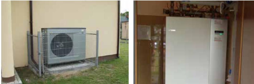
Fot. 18.2. Dokumentacja fotograficzna instalacji świetlicy wiejskiej w Syrkowicach (gmina Karlino)
