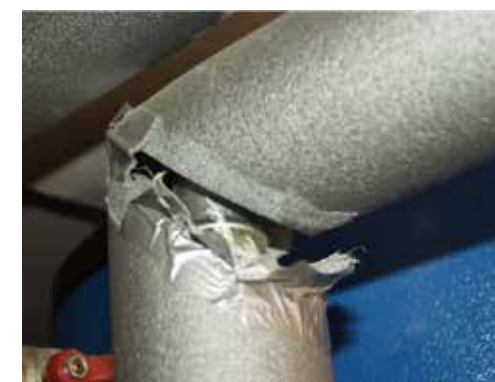
Fot. 3.3. Ilustracja dość niskiej jakości prac wykończeniowych w zakresie izolacji rur wewnątrz pomieszczeń
