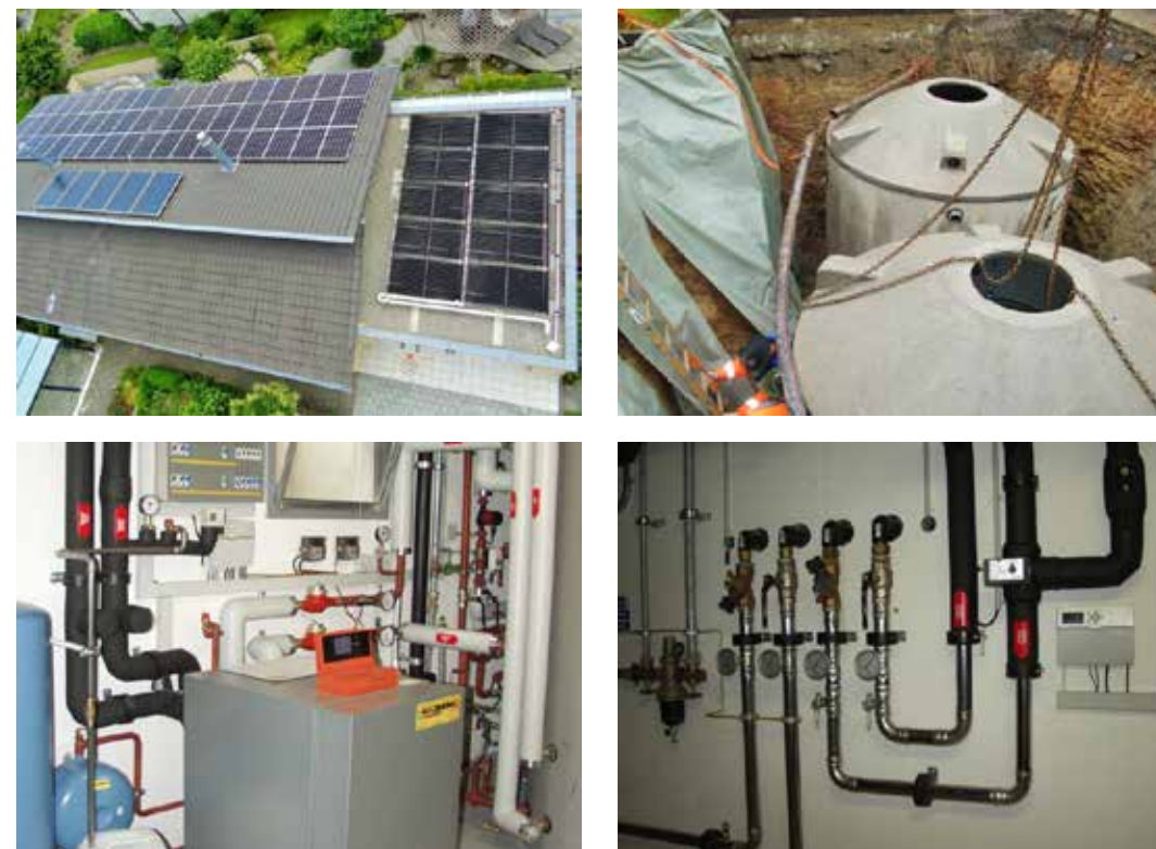
Fot. 18.5. Dokumentacja fotograficzna instalacji w domu jednorodzinny (Udligenswil, Szwajcaria – dzięki uprzejmości właściciela budynku)
