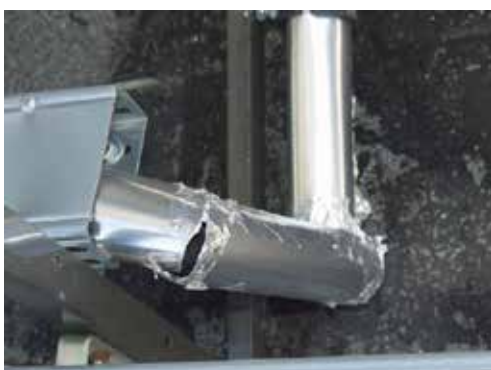
Fot. 3.1. Widok niepoprawnie wykonanych izolacji na rurociągach zewnętrznych: brak izolacji, niewłaściwy materiał izolacji, zbyt mała grubość izolacji, nadmiernie rozbudowana sieć rurociągów, brak płaszcza ochronnego, brak solidnego wykończenia prac montażowych
