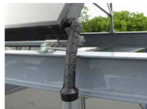
Fot. 3.4. Przykłady instalacji godnych naśladowania w zakresie wykonania izolacji, zabezpieczenia rurociągów na zewnątrz oraz przejść dachowych (Polska)
