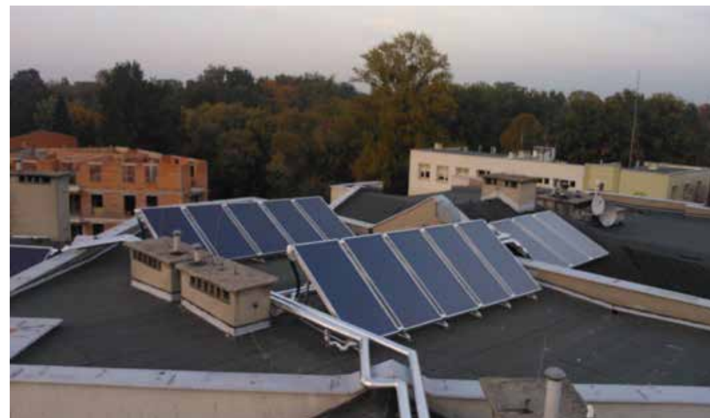
Fot. 10.6. Ilustracja instalacji kolektorów słonecznych WM w Kaliszu (Polska)
