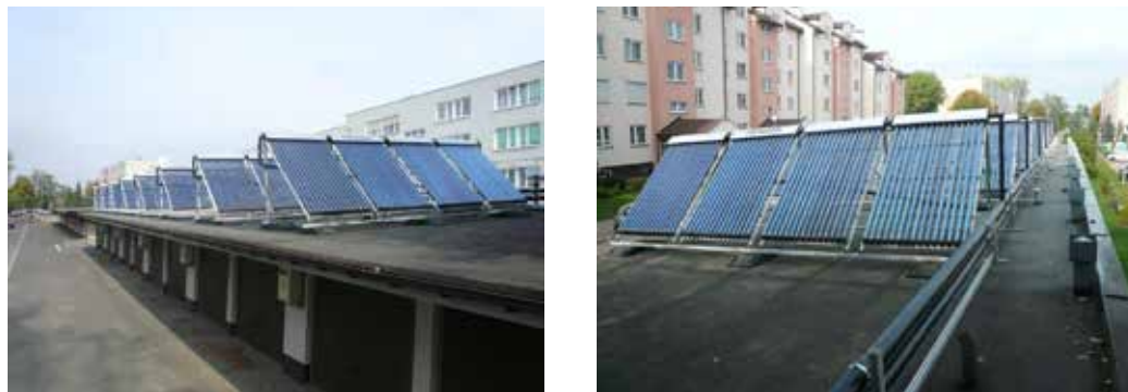
Fot. 10.2. Ilustracja instalacji kolektorów słonecznych WM Krosno (Polska)
