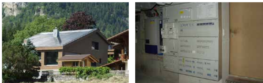
Fot. 18.4. Dokumentacja fotograficzna instalacji w domu jednorodzinny (Brienz, Szwajcaria – dzięki uprzejmości właściciela budynku)
