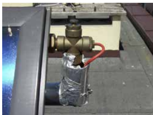
Fot. 3.1. Widok niepoprawnie wykonanych izolacji na rurociągach zewnętrznych: brak izolacji, niewłaściwy materiał izolacji, zbyt mała grubość izolacji, nadmiernie rozbudowana sieć rurociągów, brak płaszcza ochronnego, brak solidnego wykończenia prac montażowych
