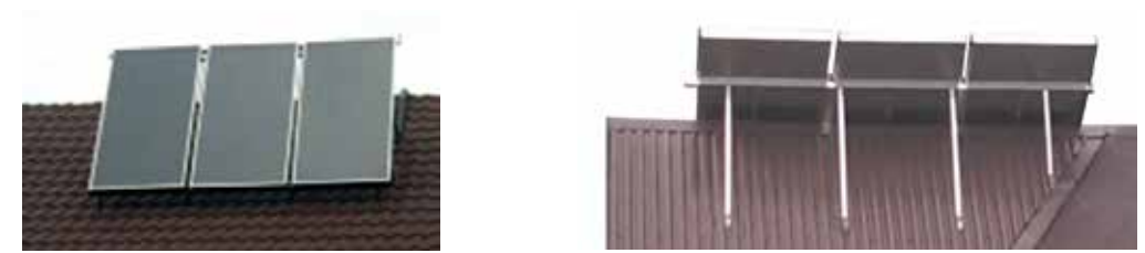
Rys. 2.10. Niezalecane sposoby montażu kolektorów
