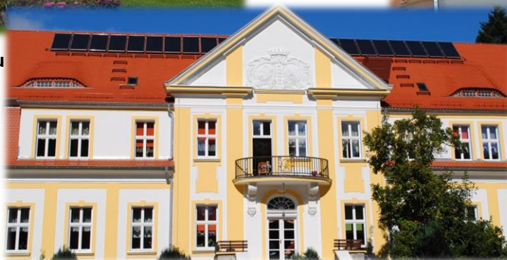
Kolektory słoneczne na budynku Domu Pomocy Społecznej w Krzecku
