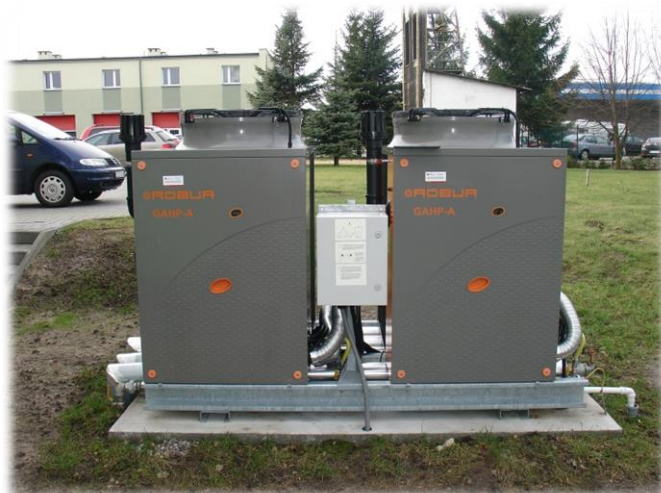
Gazowe absorpcyjne powietrzne pompy ciepła w KPPSP w Szczecinku
