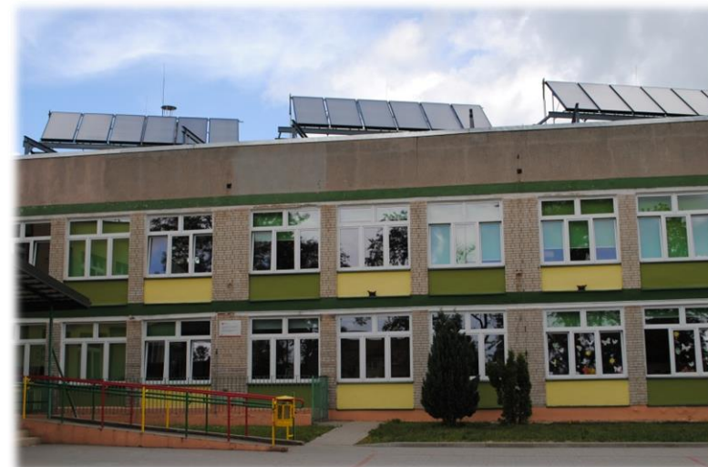
Kolektory słoneczne na budynku Szkoły Podstawowej nr 2 w Sianowie
