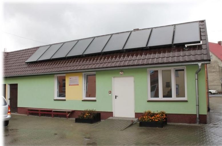
Kolektory słoneczne na budynku POW „Dzieciowisko” w Świdwinie
