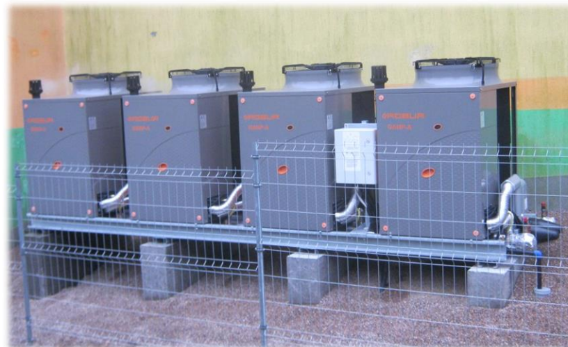
Gazowe absorpcyjne powietrzne pompy ciepła w Ośrodku Szkolno - Wychowawczym w Szczecinku
