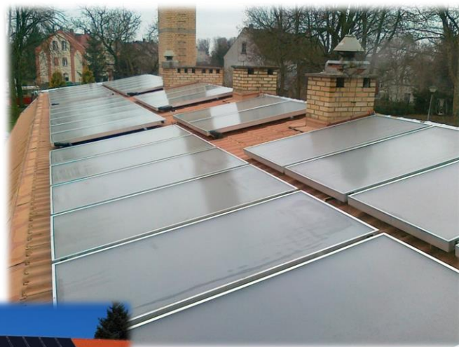
Kolektory słoneczne na budynku Domu Pomocy Społecznej w Gościnie
