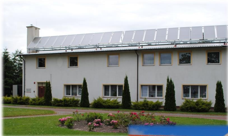
Kolektory słoneczne na budynku Domu Pomocy Społecznej w Modrzewcu
