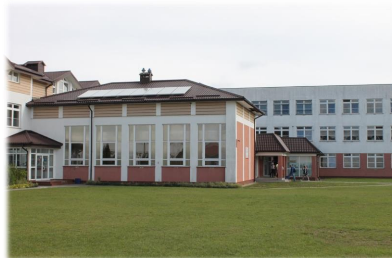
Kolektory słoneczne na budynku Publicznego Gimnazjum w Połczynie - Zdroju
