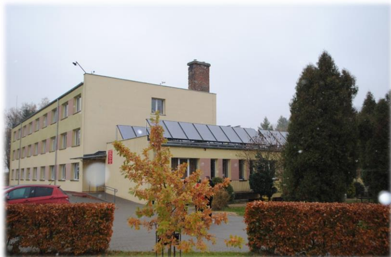
Kolektory słoneczne na budynku Zespołu Szkół Rolniczych CKP w Świdwinie
