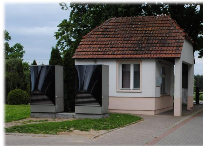
Pompy ciepła powietrze – woda w Domu Pomocy Społecznej w Modrzewcu
