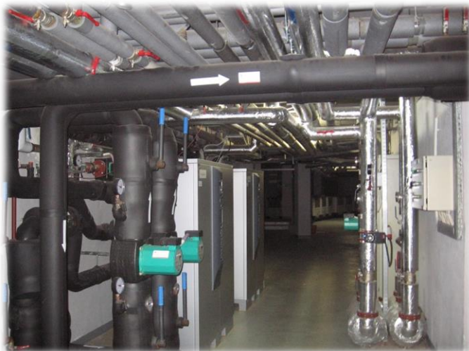
Pompy ciepła gruntowe typu solanka – woda w budynku Basenu AQUATUR w Szczecinku
