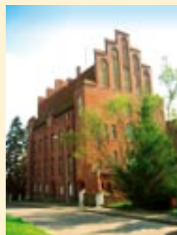
Budynek dawnego Sądu Grodzkiego
