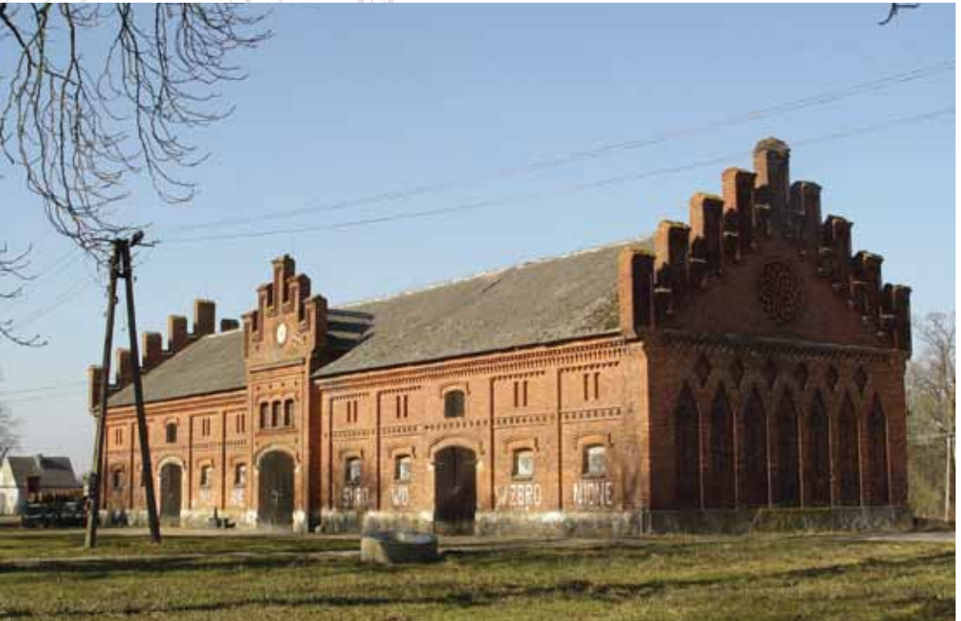
Neogotycka owczarnia murowana z czerwonej cegły z 1865 r.
