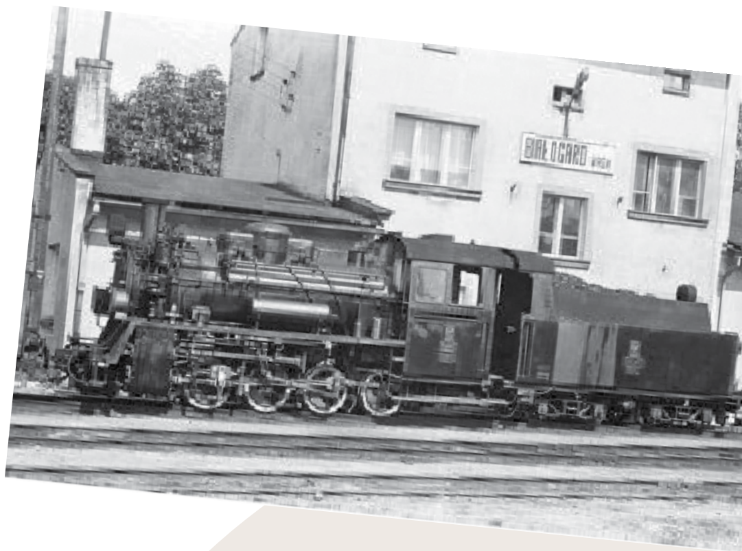
Na górze: Stacja kolejki wąskotorowej w Białogardzie. Lokomotywa Px48-3916 z Fabryki Lokomotyw w Chrzanowie 1950, szerokość toru 1000 mm.
