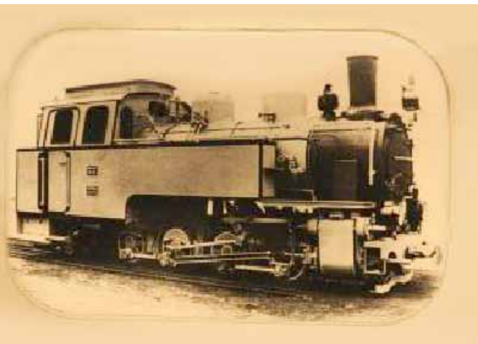
Parowóz TENDRZAK, 750 mm, pięcioosiowy (0-4-1), nr 10 SA ZKWPKBiB, zbudowany w 1925 r. przez firmę Borsig w Berlinie.
